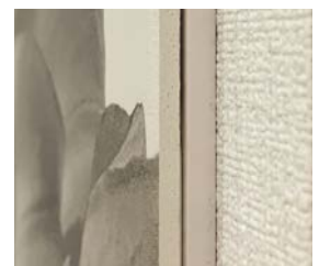
パネルキット側面部の納まり例 パネルキットの側面はエコカラットプラスの側面とパッキンが見える納まりになります。
